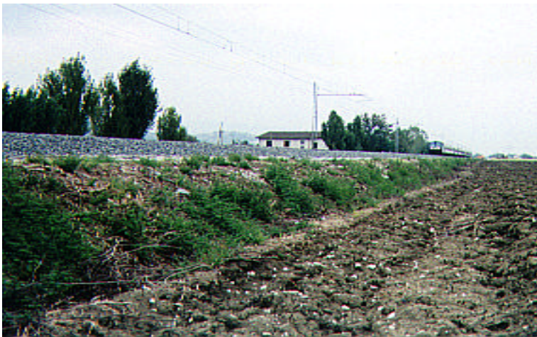
Foto n° 2 – Particolare di una zona prima degli interventi.
