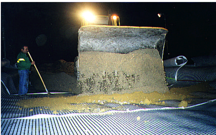
Foto n° 3 – Posa in opera del materiale granulare sul geocomposito.
