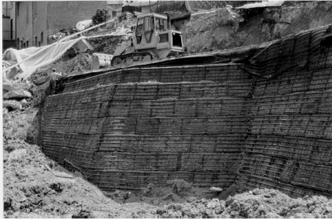
Fig. 4: il rilevato durante la costruzione
