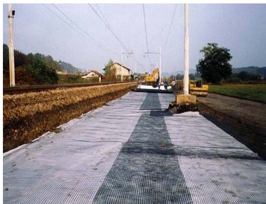
Figura 6: Fasi di sbancamento del rilevato esistente e stesa del geocomposito nella parte di massiccata ferroviaria soggetta a ripristino
