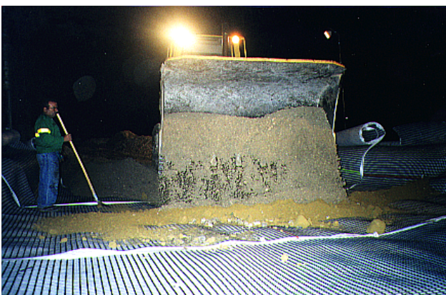
Figura 2: a) particolare di una zona prima degli interventi; b) posa in opera del materiale granulare sul geocomposito durante la notte
