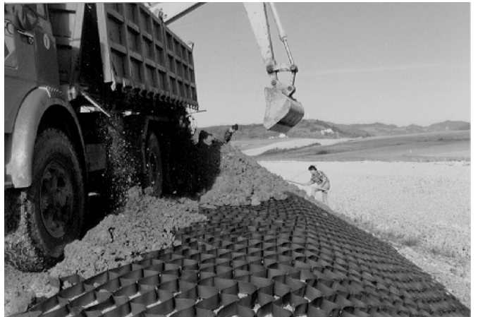
Fig. 4 -Riempimento della trincea di ancoraggio
