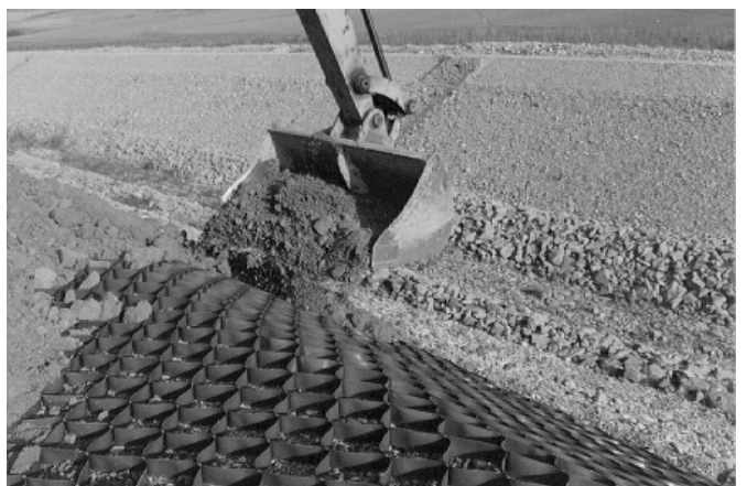
Fig. 5 - Riempimento delle celle
