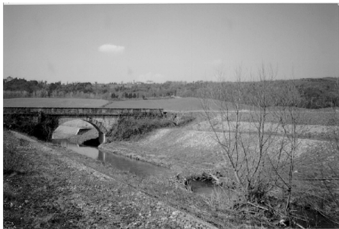
Fig. 10 - L'aspetto delle sponde a 6 anni dall'intervento.
