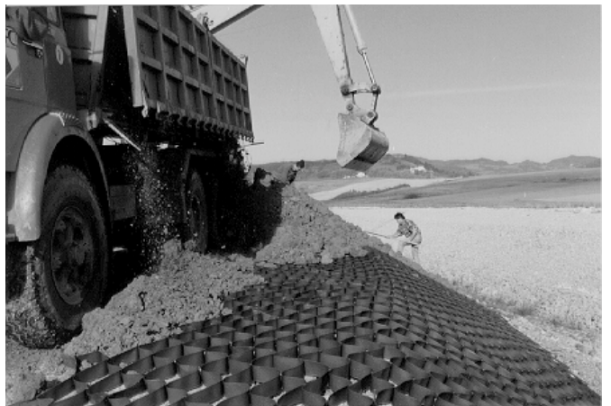
Fig. 4 - Riempimento della trincea di ancoraggio
