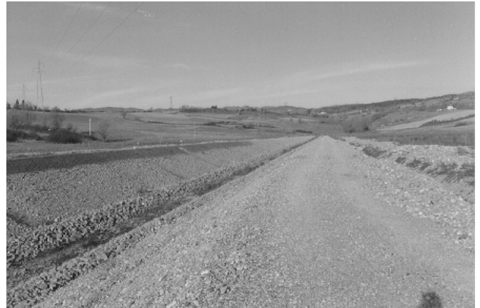
Fig. 3 - Preparazione degli argini
