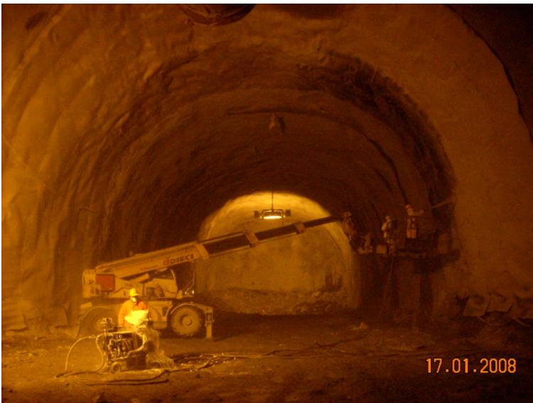
Applicazione del Masterseal 345
