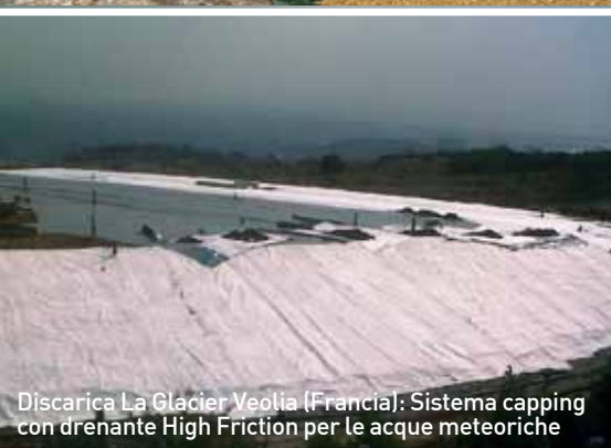
Discarica La Glacier Yeolia (Francia); Sistema capping con drenante High Friction per le acque meteoriche
