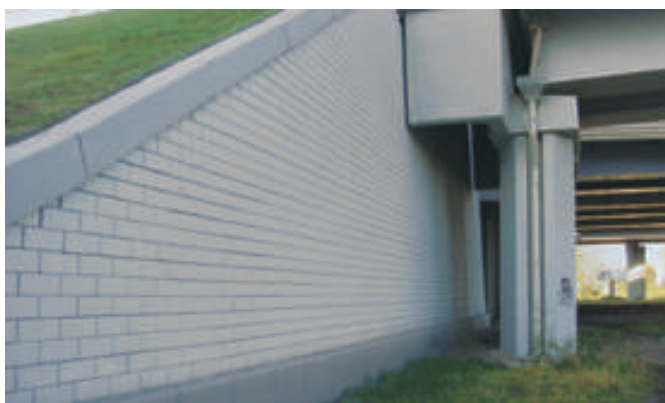
Raccordo con strutture in c.a.
