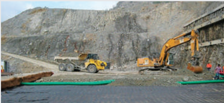
Posizionamento di tubazioni per il drenaggio.
