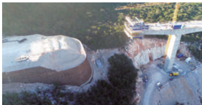
Spalla di ponte, Peljesac Bridge, Croazia.
