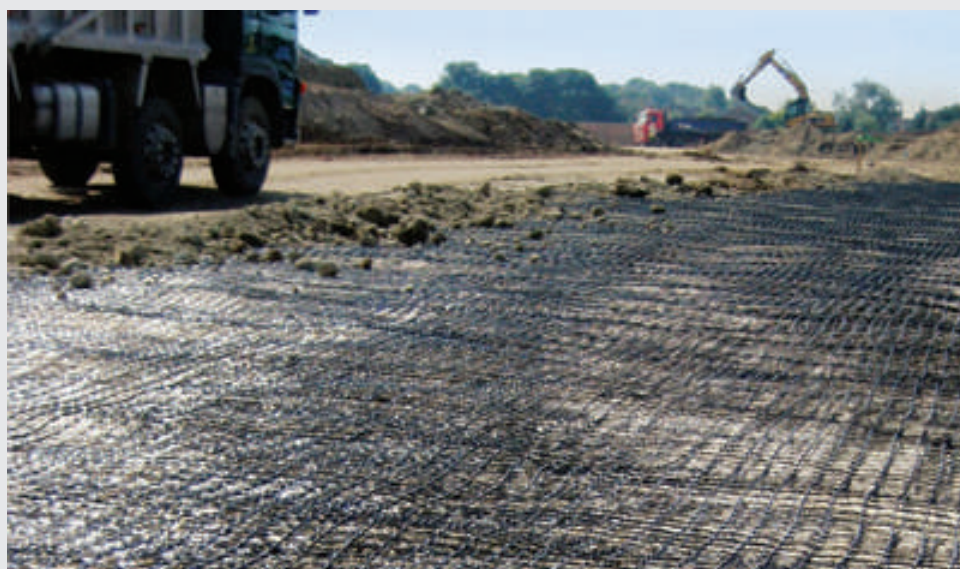
Abraham Darby Academy, Telford, Shropshire. Applicazione di 10'000 m 2 di geogriglia TENAX 3D Grid MS per la stabilizzazione del terreno prima della realizzazione di una scuola primaria.
