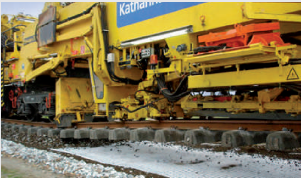
Mantgum, Paesi Bassi. Il rinnovo della massicciata del binario della Frisia è stato completato utilizzando un treno per la pulizia della massicciata che viaggia a 3 m/s posizionando contemporaneamente un geocomposito per stabilizzare l'interfaccia zavorra/sottotondo e per ridurre al minimo il movimento verso l'alto dei finì del sottotondo.
