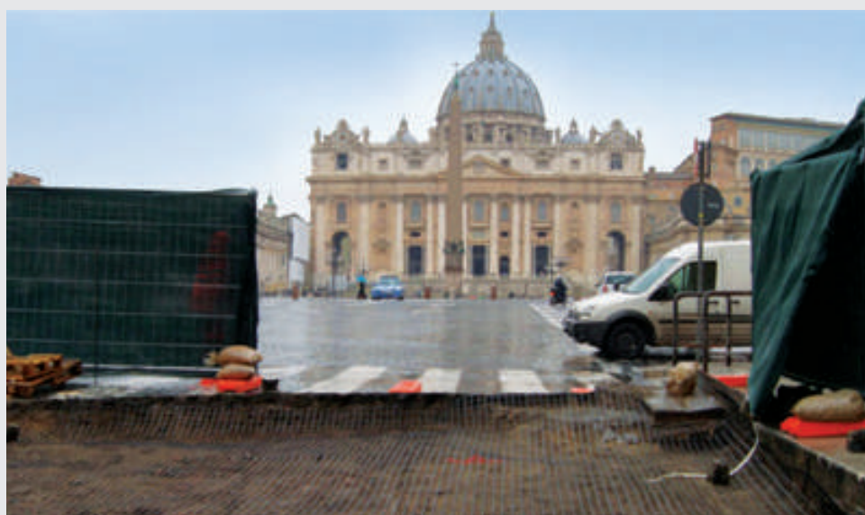
Roma, Basilica di San Pietro. Stabilizzazione del pavimento adiacente alla basilica con l'utilizzo del prodotto TENAX 3D GRID XL.
