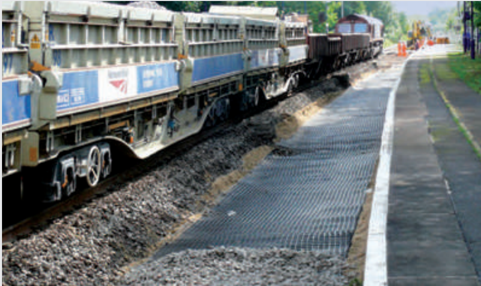
Midgham, Inghilterra. Geogriglie TENAX installate per aumentare le prestazioni della massicciata e ridurre le frequenze di manutenzione.
