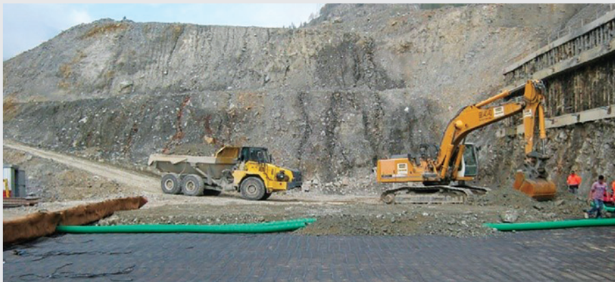
Posizionamento di tubazioni per il drenaggio.
