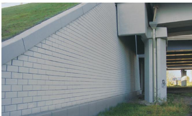
Raccordo con strutture in c.a.
