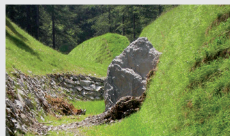
Masso roccioso fermato da paramassi in terra rinforzata in località Créton nel Comune di Rhêmes Saint-Georges (AO).
