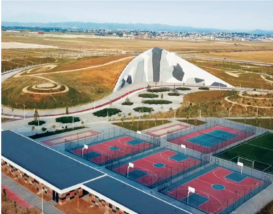
Ecopark Durazzo: argine in terra rinforzata di 21 m di altezza per riduzione spinte su muro da arrampicata sportiva con altezza di 28 m.
