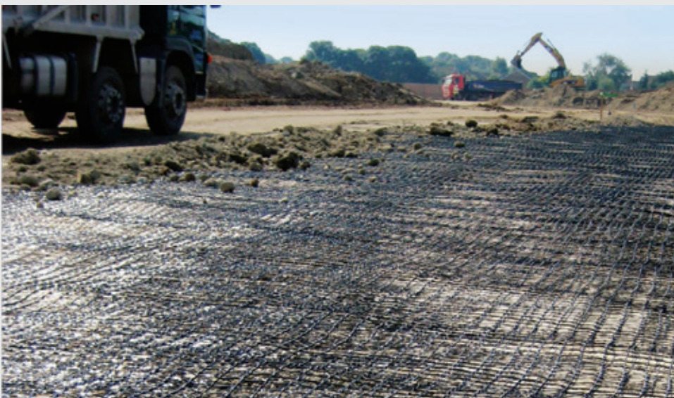
Abraham Darby Academy, Telford, Shropshire. Applicazione di 10'000 m 2 di geogriglia TENAX 3D Grid MS per la stabilizzazione del terreno prima della realizzazione di una scuola primaria.
