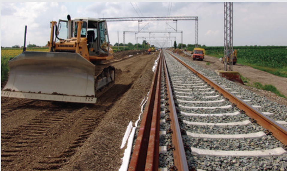
Vinkovci/Tovarnik, Croazia. Rinforzo con geogriglia TENAX della massciata ferroviaria. 185.000 m 2 di geogriglia sono stati installati per la ferrovia croata.
