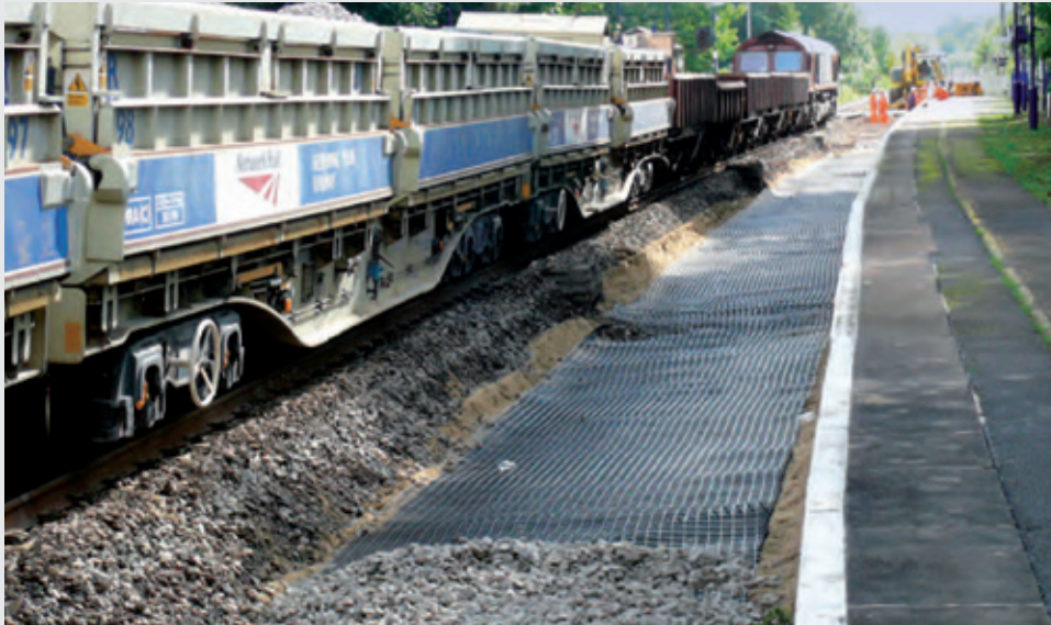
Midgham, Inghilterra. Geogriglie TENAX installate per aumentare le prestazioni della massciata e ridurre le frequenze di manutenzione.
