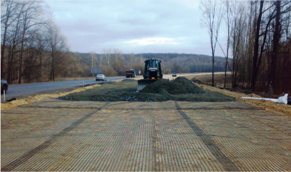
Ucraina, applicazione della geogriglia TENAX 3D GRID XL per la stabilizzazione di una strada.
