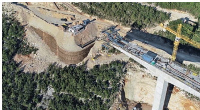
Spalla di ponte, Peljesac Bridge, Croazia.
