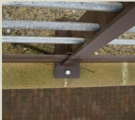
Fissaggio parapetto - muro a blocchi
