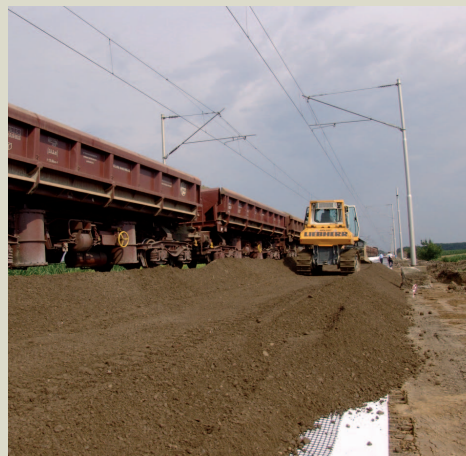
Operazioni di posizionamento del terreno Operazioni di stendimento e rullatura
