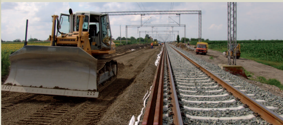
L'area dopo i lavori
