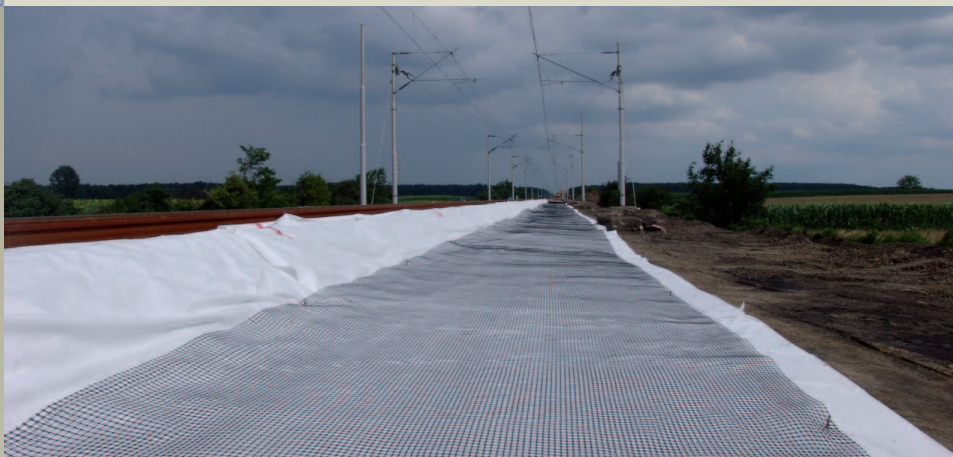
L'area dopo la posa del geotessile e delle geogriglie
