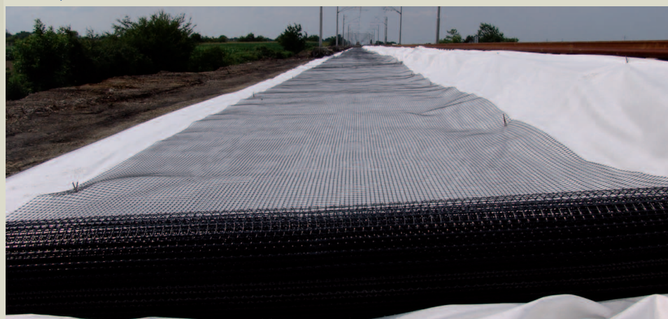
Posa del geotessile nontessuto e delle geogriglie
