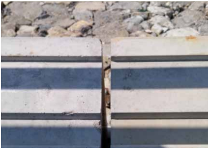
Dettaglio spaziatura blocchi
