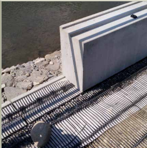
Dettaglio ancoraggio geogriglia
