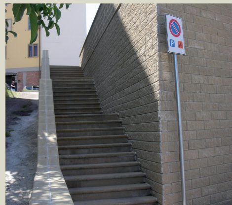
Scala di accesso all'area a verde
