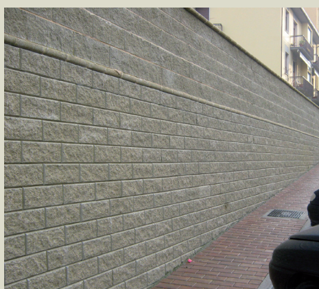
Facciata con parapetto a blocchi
