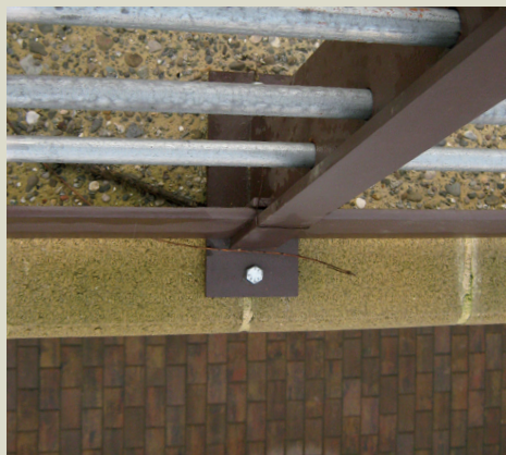
Fissaggio parapetto - muro a blocchi
