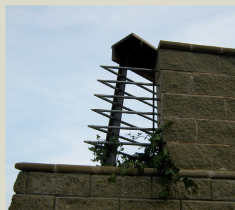
Dettaglio innesto parapetto metallico
