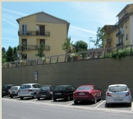
Panoramica del muro a blocchi
