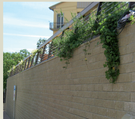
Facciata con parapetto metallico
