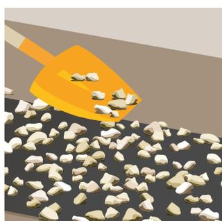
Solo in situazioni particolari, dove sia necessario assicurarsi un perfetto drenaggio dell'acqua, stendere sopra al telo antiradice uno strato di ghiaia o un composito drenante.
