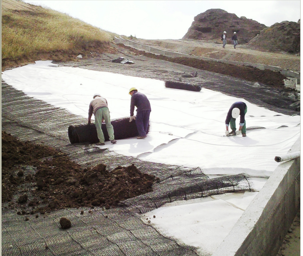
La geostuoia MULTIMAT R viene stesa al di sopra del geocomposito filtro drenante TENAX HF
