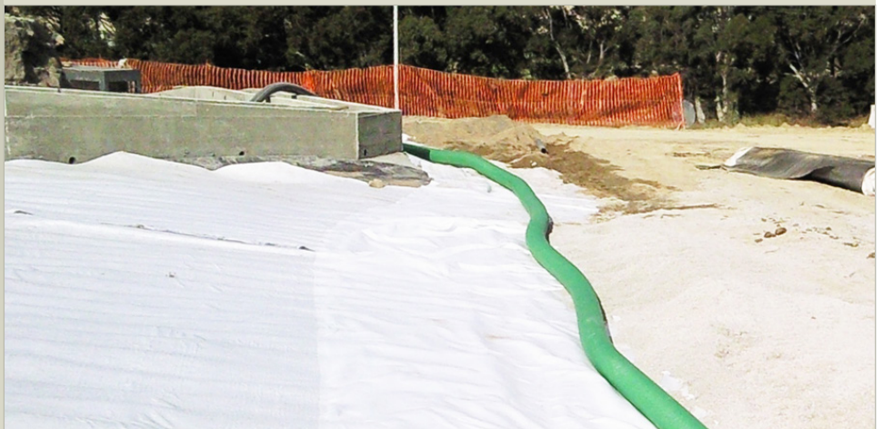
Posa dei tubi corrugati per il sistema di drenaggio principale
