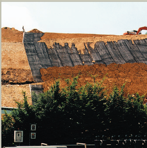
Stesa del terreno di coltivo sulla geostuoia tridimensionale
