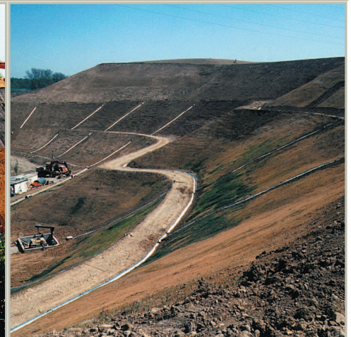
L'intervento ultimato in attesa dell'inerbimento.
