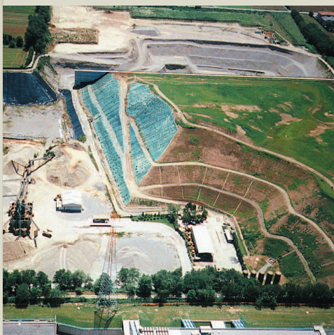
Posa in opera della geostuoia tridimensionale rinforzata TENAX MULTIMAT 110 R .
