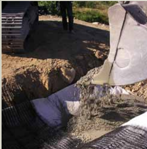
Posa ed ancoraggio delle geostuoie TENAX MULTIMAT R
