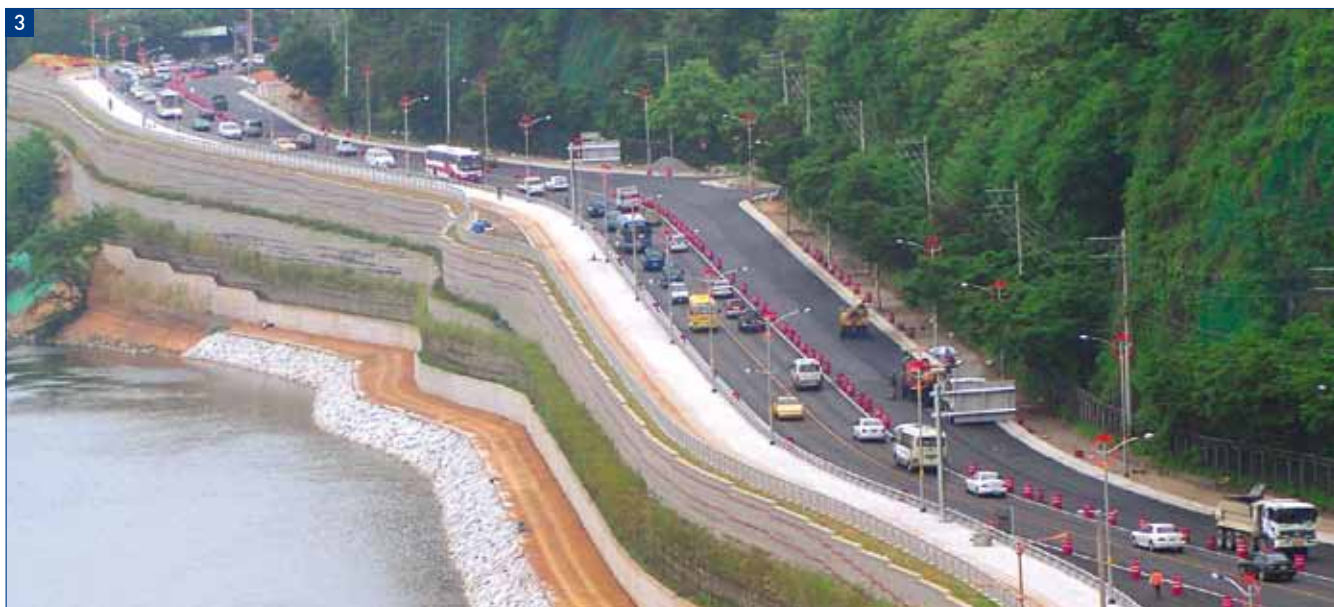
Foto 3: Corea del Sud, Chunsugyo/Saebeari Rilevato autostradale realizzato con soluzione mista terre rinforzate - sistema TENAX T-BLOCK.
