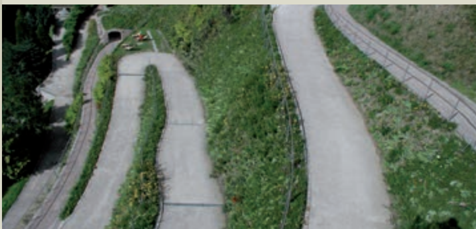
Panoramiche dei muri in terra rinforzata
