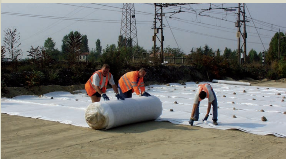
Operazioni di posa del geocomposito
