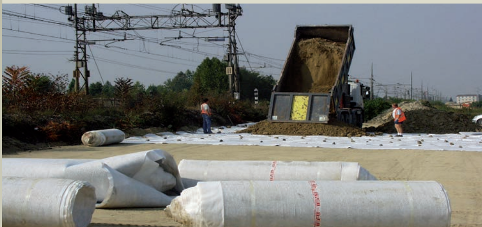
Operazioni di posa del geocomposito
