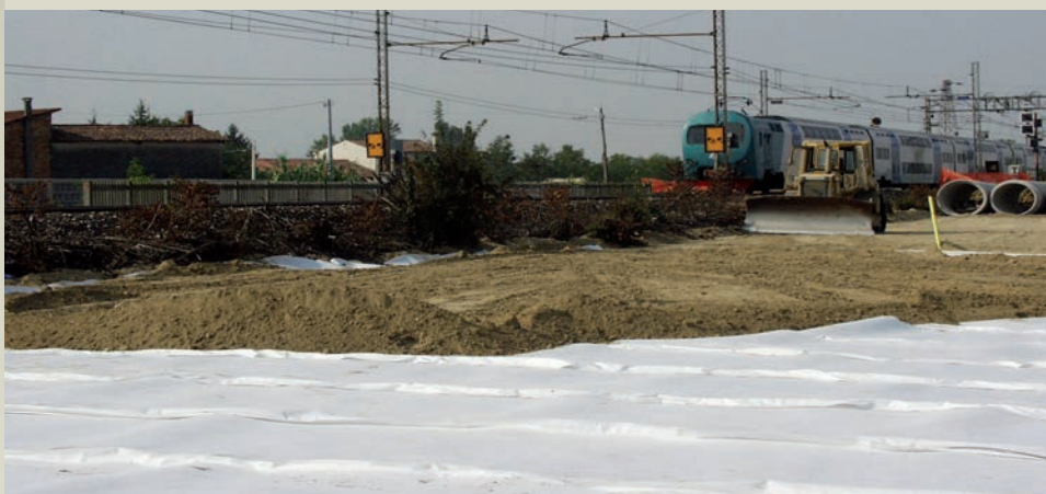
Operazioni di scarico e stendimento dello strato superiore di terreno
