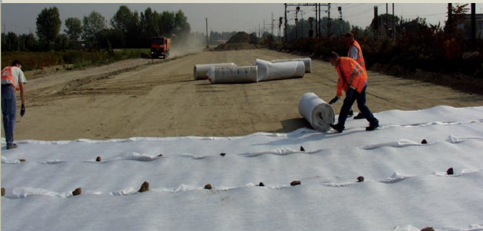
Operazioni di posa del geocomposito
