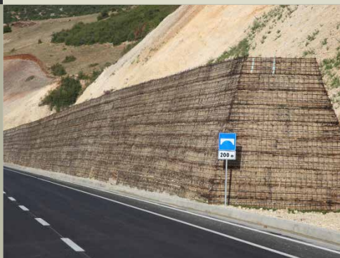
Vallo di protezione in terra rinforzata
