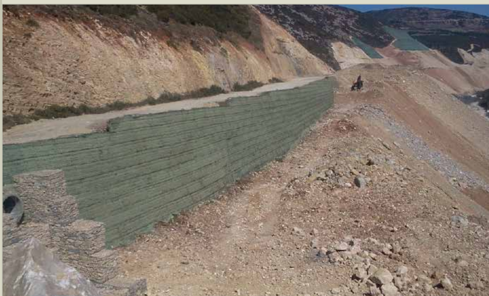
Rilevato stradale in terra rinforzata, sistema Tenax River
