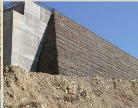
Innesto al viadotto
