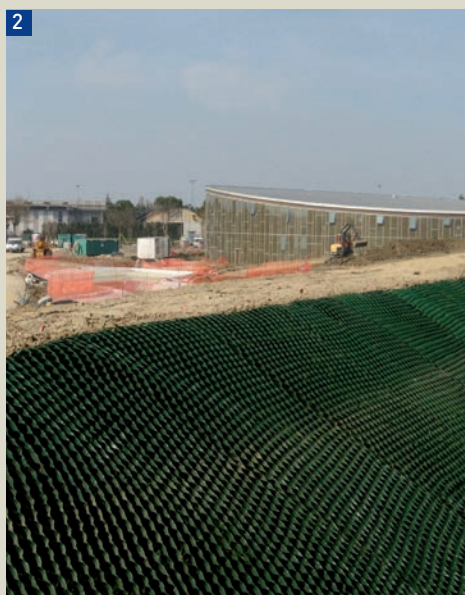
1. Stesa del terreno - 2. Messa in opera delle Geocelle - 3. Pronto effetto a un mese dalla messa a dimora delle piante
