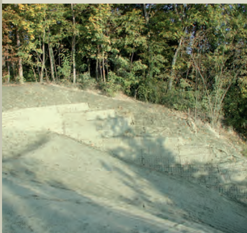
Scarpata stabilizzata con TENAX Rivel a fine lavori e dopo il rinverdimento
