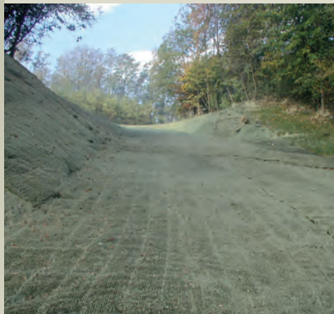
Area sbancata dopo la posa di Tenax Multimat e dopo il rinverdimento
