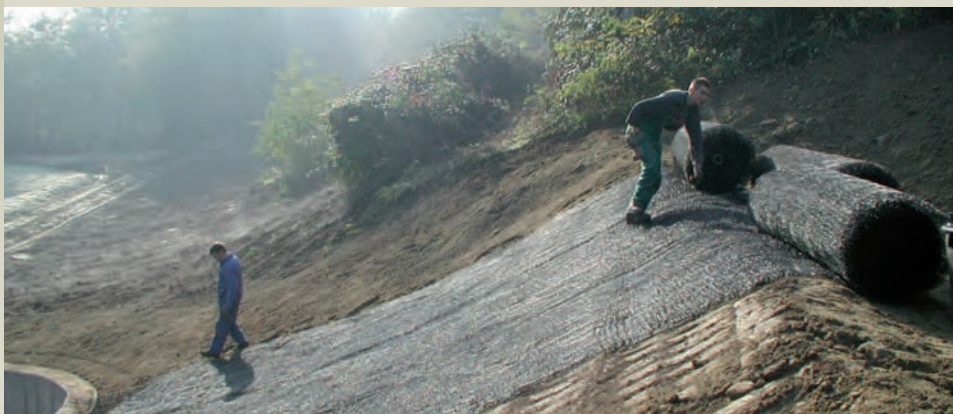
Operazioni di stendimento di TENAX Multimat
