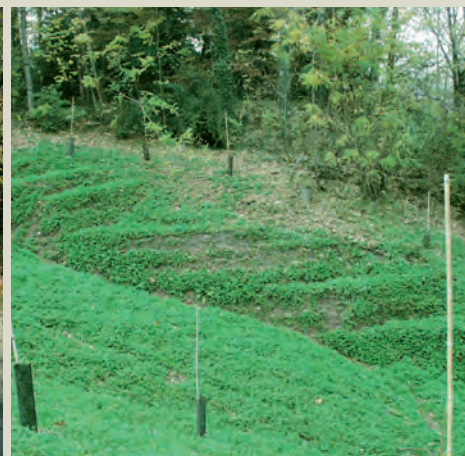
Scarpata stabilizzata con TENAX Rivel a fine lavori e dopo il rinverdimento
