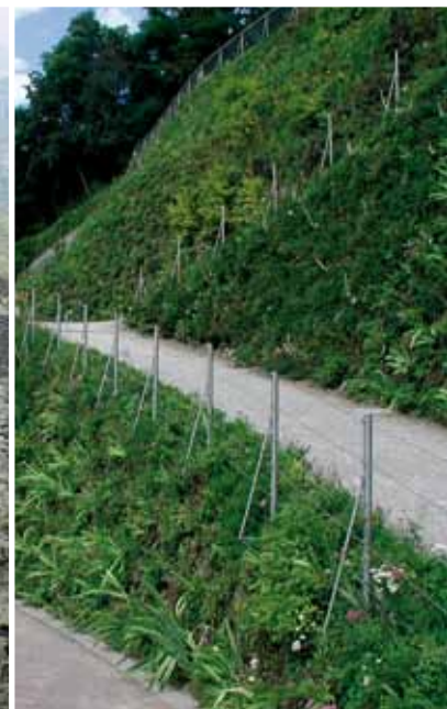
giardini sub-verticali in terra rinforzata nell'Orto Botanico Trautmannsdorf, Merano
