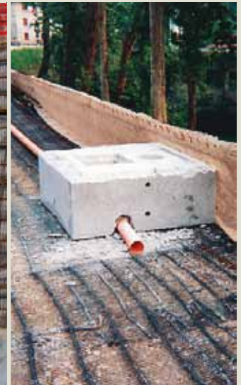
Prima del riempimento dell'ultimo corso del rilevato è possibile realizzare i pozzetti in cemento che contengono i pali d'illuminazione stradale.
