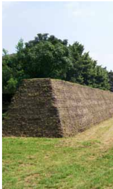
Barriera Fonoassorbente sulla Tangenziale Est di Milano in prossimità del Centro Commerciale Torri Bianche di Vimercate (MI)
