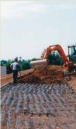
Le geogriglie vengono sovrapposte in testa o in coda a seconda che il tratto sia concavo o convesso.
