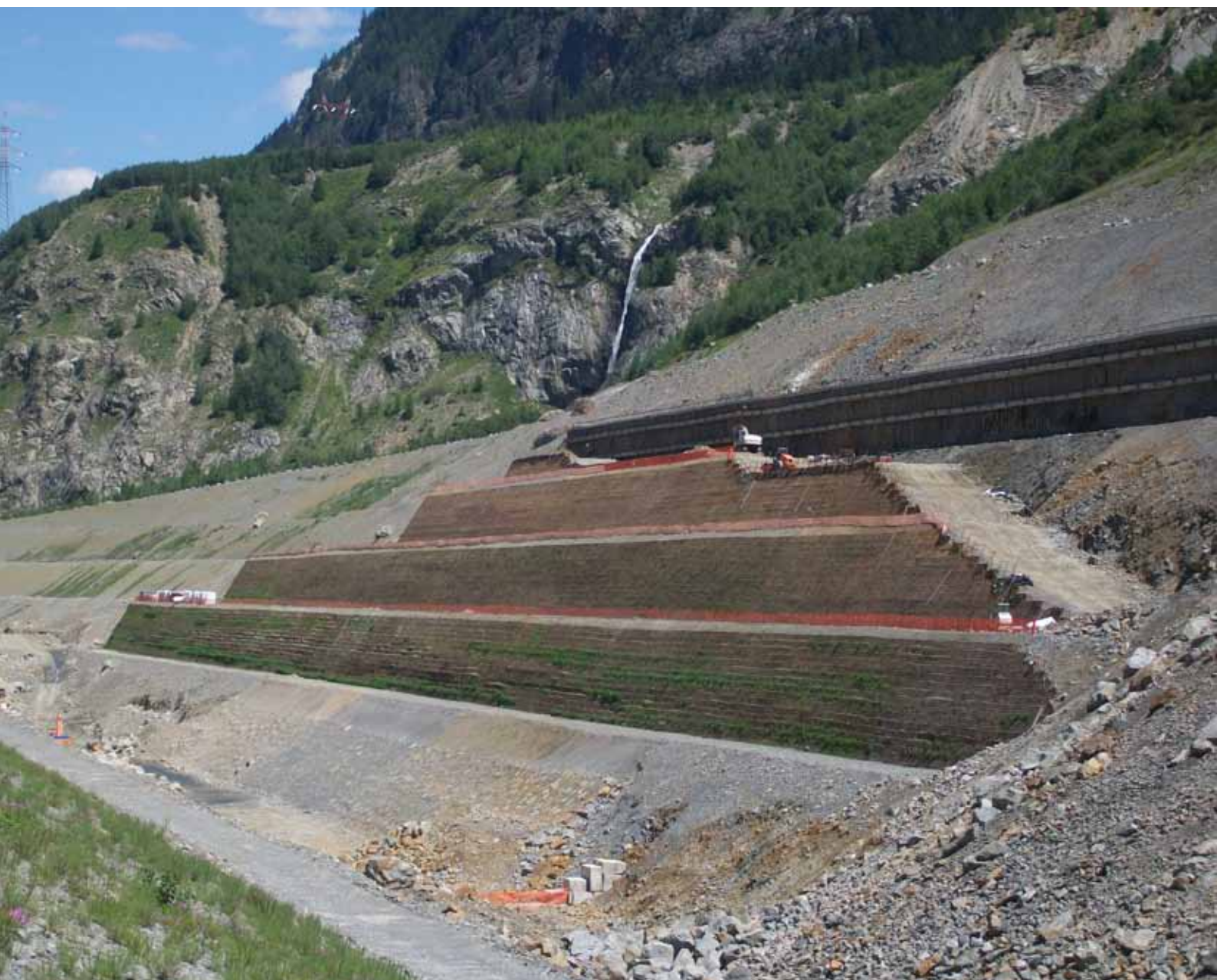
25.000mq di facciata di Terre Rinforzate nell'ambito degli interventi di sistemazione idraulica dell'area interessata dalla Frana della Val Pola – So
