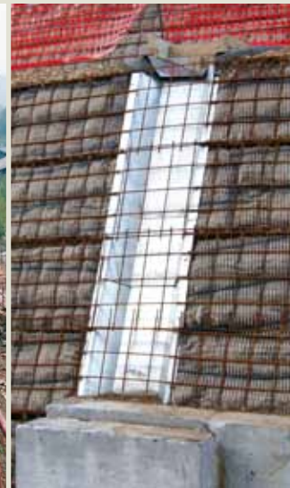
Posizionamento degli embrici metallici per il deflusso delle acque superficiali.
