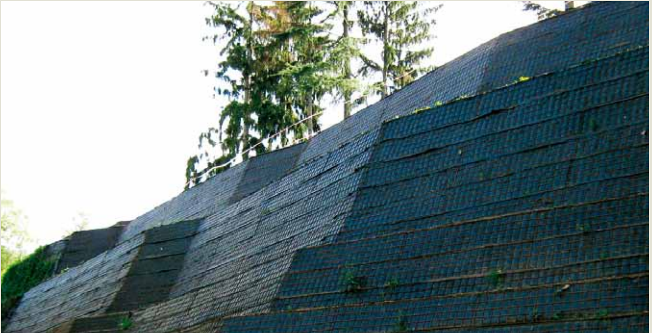
Le geogriglie vengono sovrapposte in testa o in coda a seconda che il tratto sia concavo o convesso.
