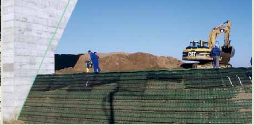
Particolare dell'angolo di raccordo della terra rinforzata con strutture già esistenti in cemento armato (tipo muri d'ala, spalle di ponte).
