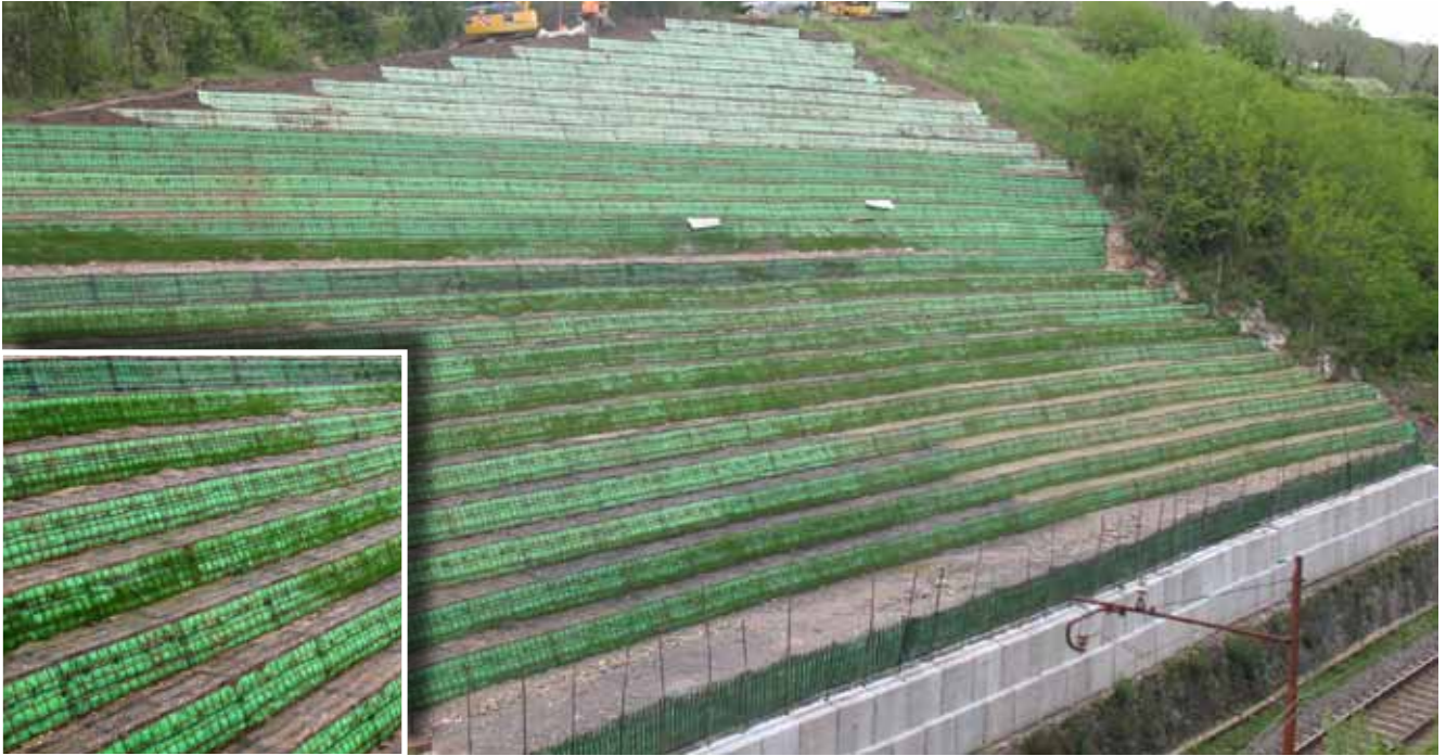
Ripristino pendio franato (h.20m) in località Serravalle Pistoiese (PT) sulla linea ferroviaria Firenze-Lucca.
