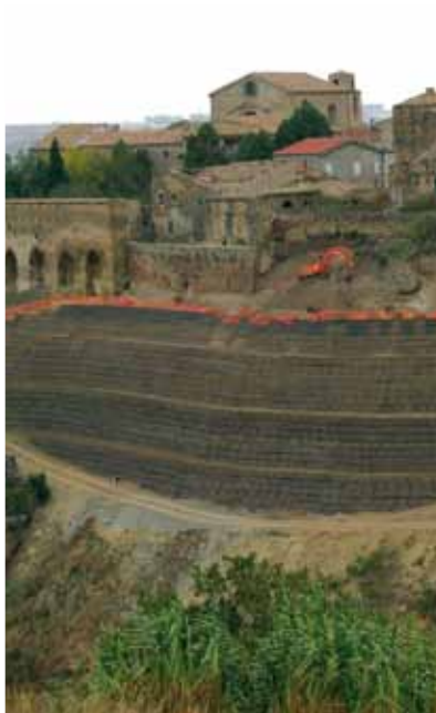
Lavori di manutenzione straordinaria e consolidamento dei costoni a Genzano di Lucania (PZ)
