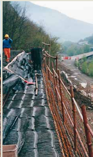
Parapetto in accordo alle normative di sicurezza in cantiere.
