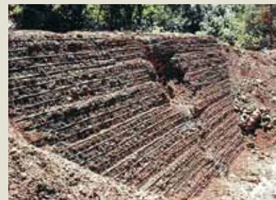
il vallo paramassi in terra rinforzata, a seguito dell'urto, è danneggiato ma integro.
