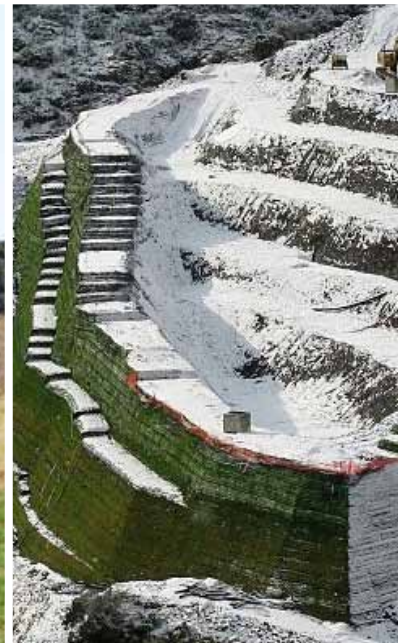
Argine perimetrale di contenimento Discarica di Villaputzu (CA)
