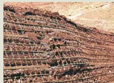
minima estrusione della facciata di valle del rilevato.
