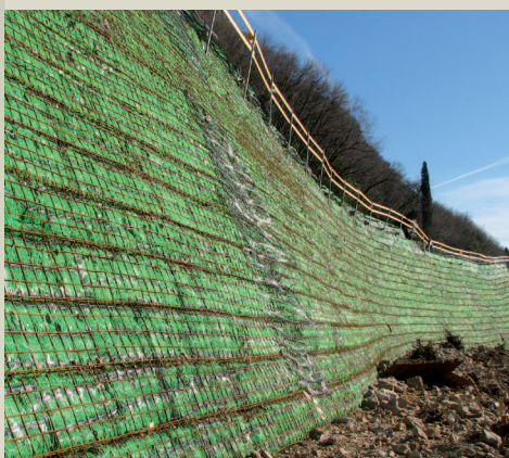
Dettaglio facciata con casseri a perdere
