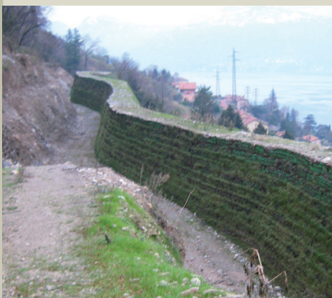
Le terre rinforzate dopo l'inerbimento
