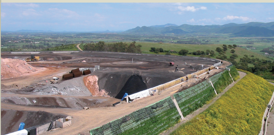
Rilevato durante l'inerbimento
