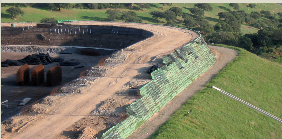
Terre rinforzate durante la costruzione
