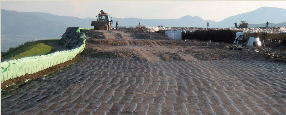
Le geogriglie TENAX durante la posa
