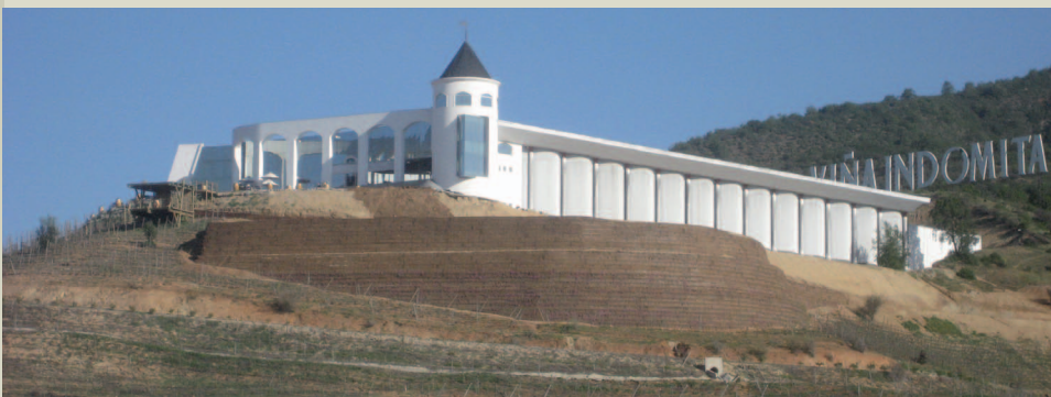
L'area dopo i lavori
