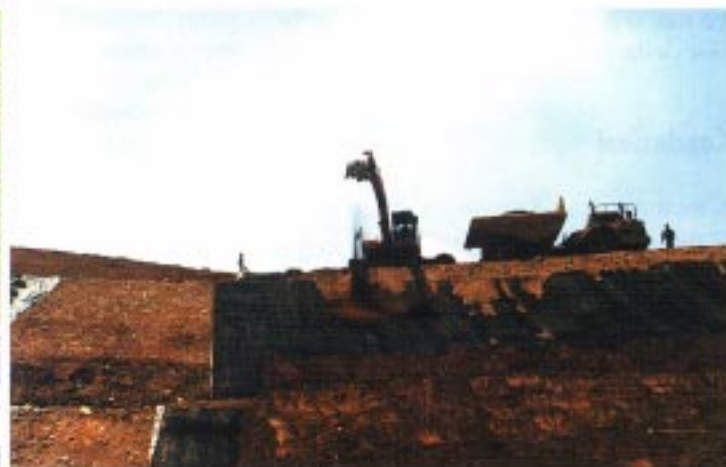
Figura 7 - Stesa del terreno di coltivo.
