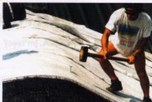
Figura 5 - Fissaggio con i chiodi zincati del pacchetto drenante-impermeabilizzante
