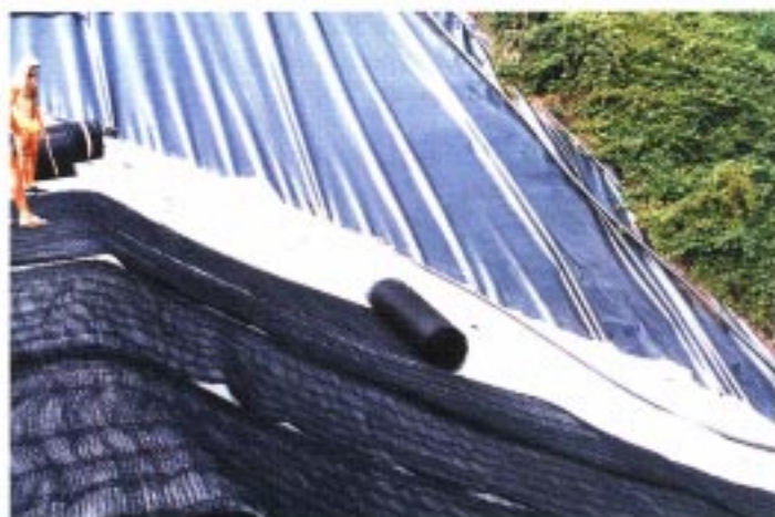
Figura 6 - Posa della geostuoia rinforzata.
